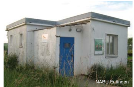
Das NABU-Vereinsheim vor dem Abbruch,
